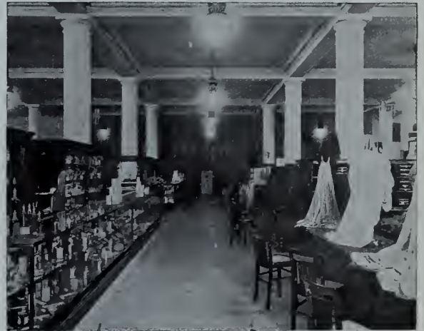
Aile transversale, 1er Etage, du côté de l'Ascenseur
