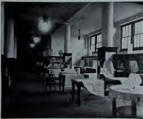
Section des toiles. Arrière de l'étage principal
